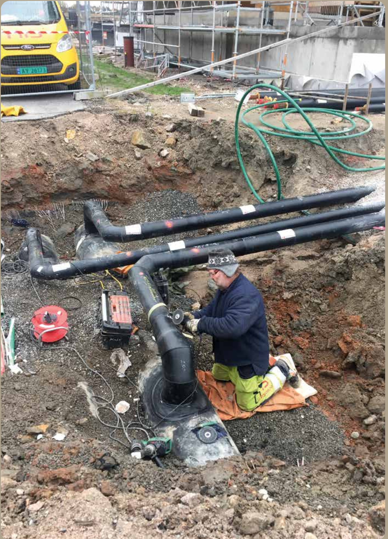
3-rørsløsning på Capjon Park for levering og mottak av varme.
