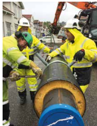
Sikring av fjernvarmerør ved styrt boring.
