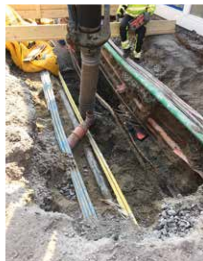
Fjerning av løsmasser ved høytrykkssuging.
