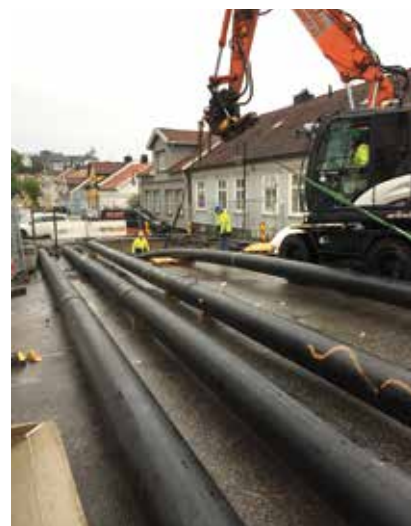
Styrt boring - inntrekking av fjernvarmerør.
