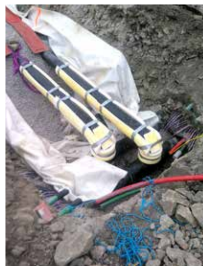
Skumputer monteres for opptak av ekspansjonskrefter.
