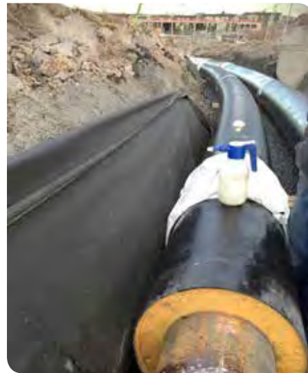
Vaggærgata - Tetthetsprøving av sveis
