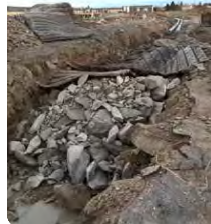
Fjell i grøfter - Sarpsborgveien
