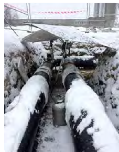
Fra grøfta på Contiga Norbetong
