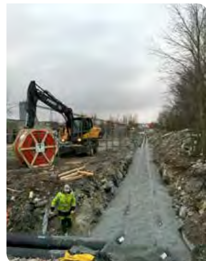
Grøft med rør - Contiga
