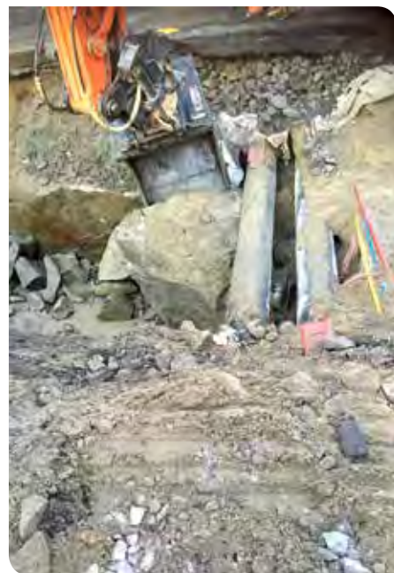
Nærsprenning for VA - eksisterende fjernvarme Farmannsgate
