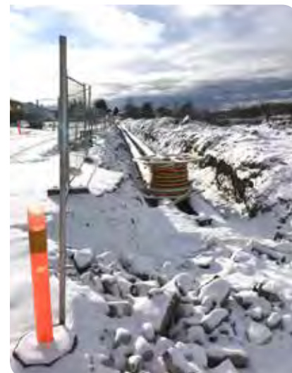
Kaldforlegging fjernvarme Sarpborgveien
