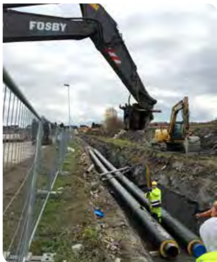
Rør ned i grøft, Sorgenfri-Allé
