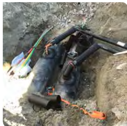
Anboring Prestelandet Boligandelslag
