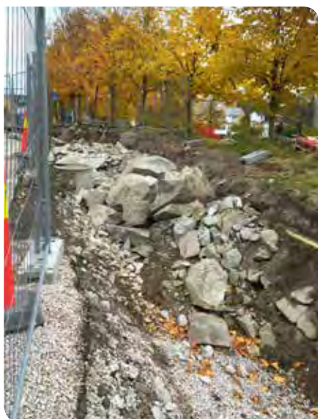
Traraveien - kiling av fjell forbi vannkum fundamentert på fjellet
