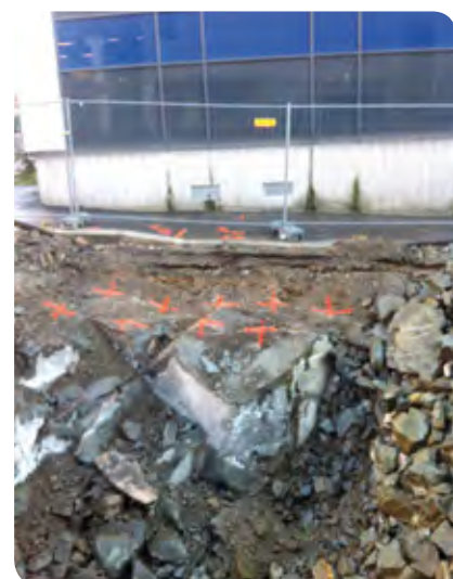
Bryggeriveien - Her må det sprenges
