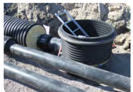
Beredskapskum for tilkobling av ekstern varmeproduksjon.
