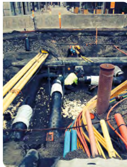
Bryggeriveien er full av infrastruktur
