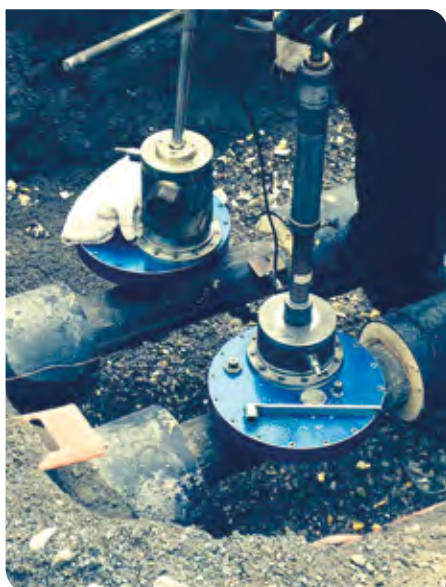
Verktøy for blokkering av fjernvarmenett i drift
