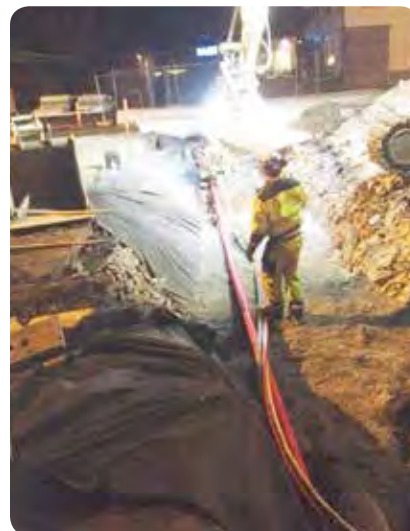
Nattarbeid, kryssing av FV109 Rolvsøyveien
