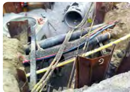
Nytt VA-anlegg krysser under fjernvarmerør i Farmannsgate
