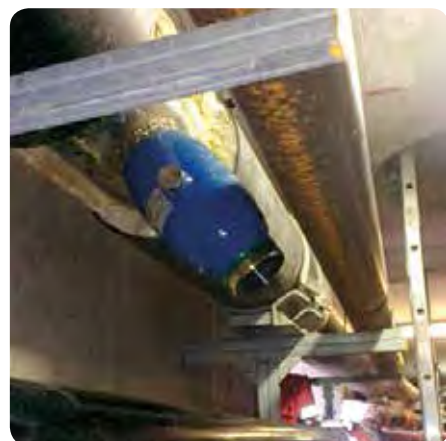
Anboring på eksisterende trase i kulvert i gågata
