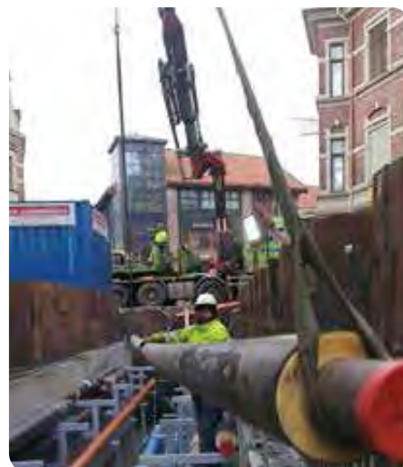
Innløfting av fjernvarmerør i kulvert i Bryggeriveien
