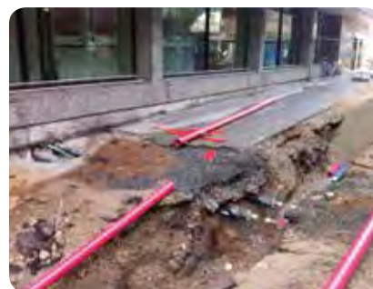
Ny ledning inn mot Nygårdsgata 55
