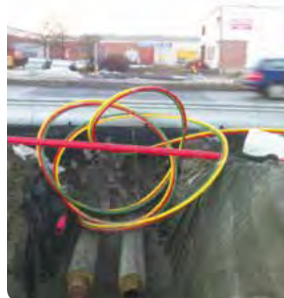
Kryssing av FV109 Rolvsøyveien ferdig på 3 netter
