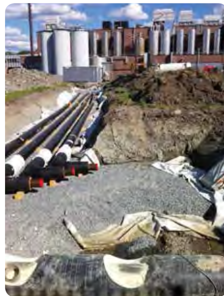
Konvertering til fjernvarme av 50 m 3 -tank for varmtvann til Mills
