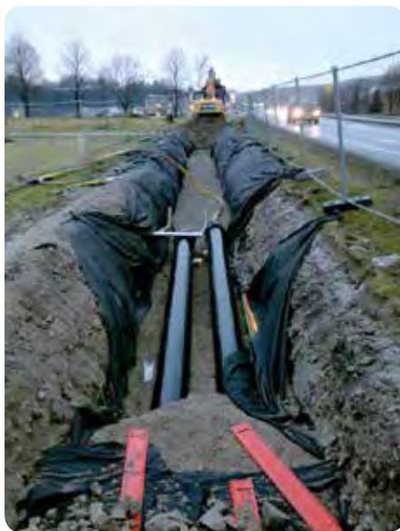
Fjernvarme i gang+sykkelvei, langs FV109 Rolvsøyveien
