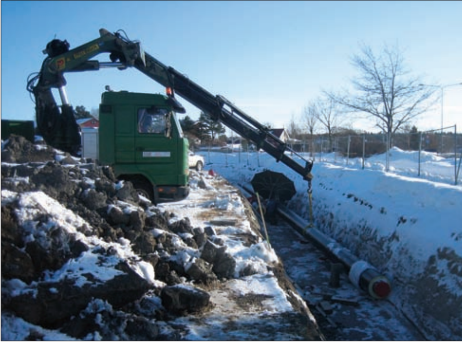
Innløfting og montering av DN 350 fjernvarmerør.
