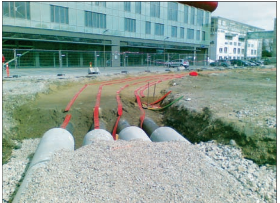
Kryssing av RV 108 på Værste med rør for fjernvarme og fjernkjøling.
