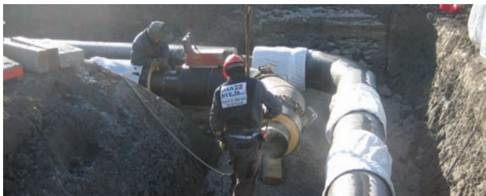
Framføring av DN 350 trasé for fjernvarme i Borgarveien.
