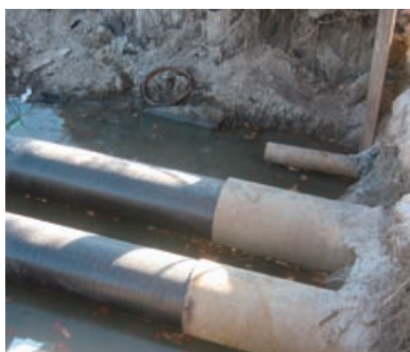
Boring av fjernvarmerør under RV 110
