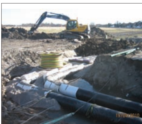
Boregrop med DN 350 rør for kryssing av RV 110
