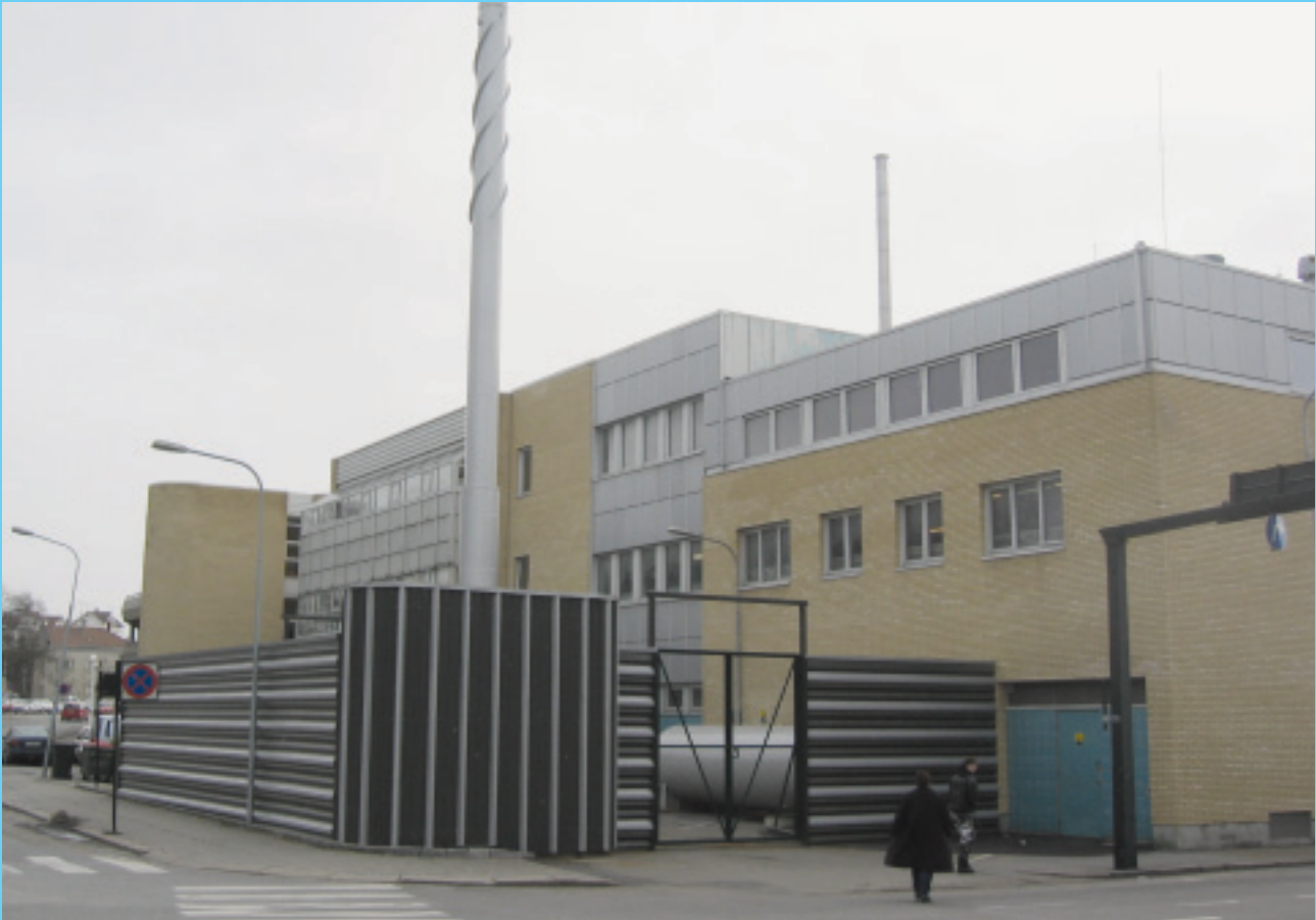
Varmesentral i Dammstredet
