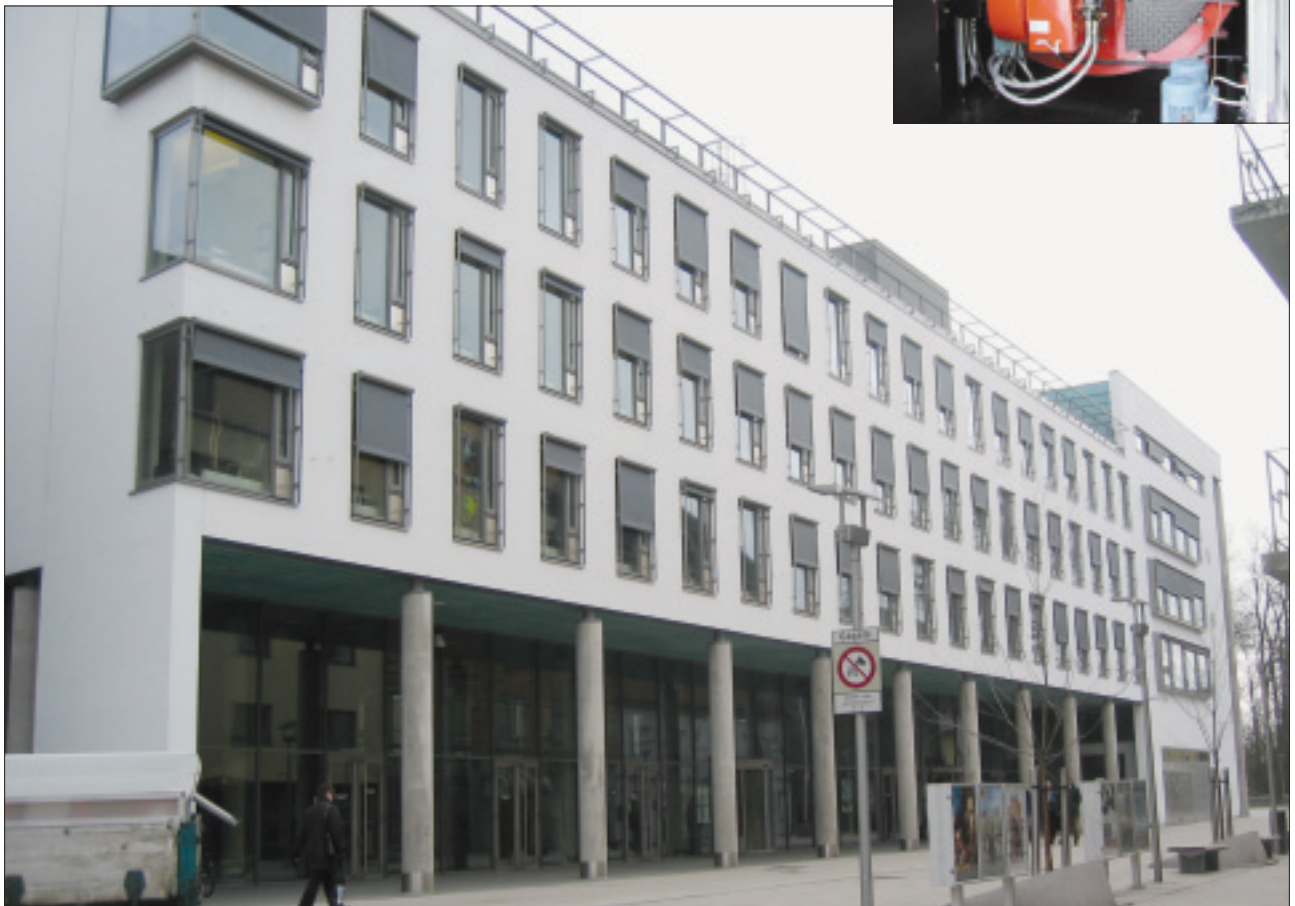
Rådhuset er fjernvarmekunde.
