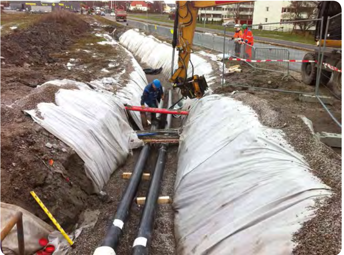
Glemmen Gård ved Ahlsell - elastisk radie på fjernvarmerørene benyttes
