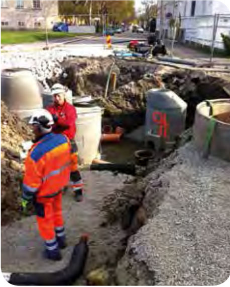
Fellesprosjekt VA/fjernvarme ved biblioteket
