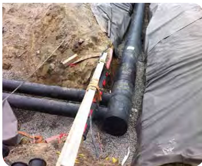
Fjernvarme Verkstedveien twin-rør for fremkommelighet
