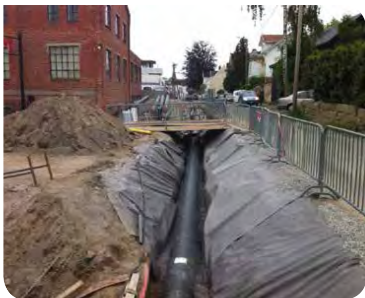
Fjernvarme Verkstedveien twin-rør for fremkommelighet
