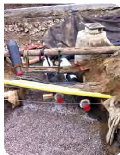
Fjernvarme mot Bjølstad – vanskelig fremkommelighet
