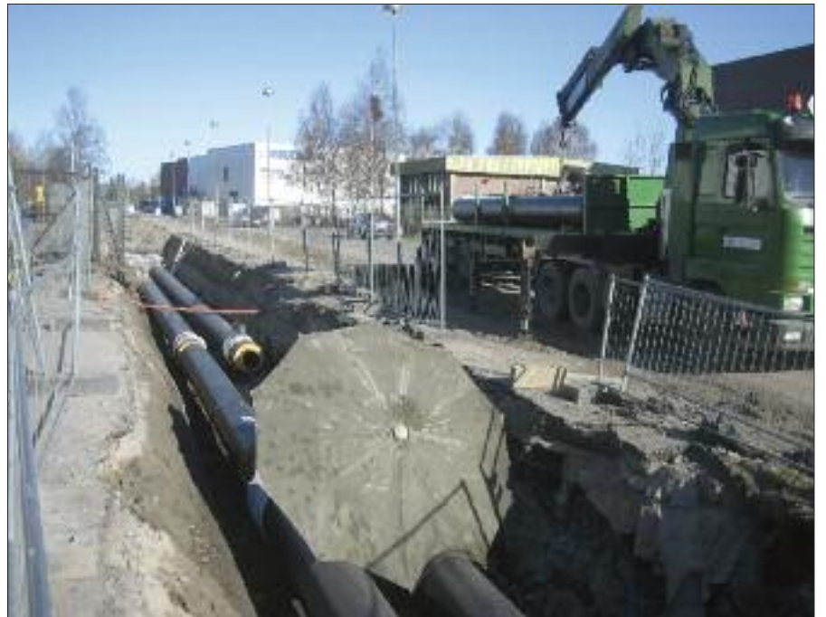
Effektiv innløfting av rør i grøft.
