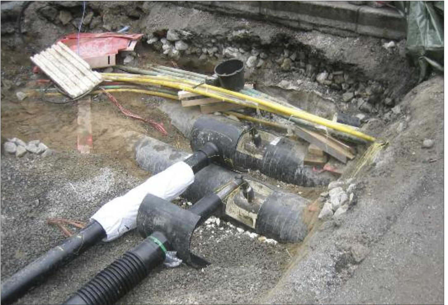
Anboring av stikkledning på hovednett.
