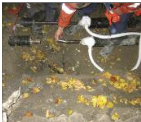
Frysing og kapping av stikkledning i drift.
