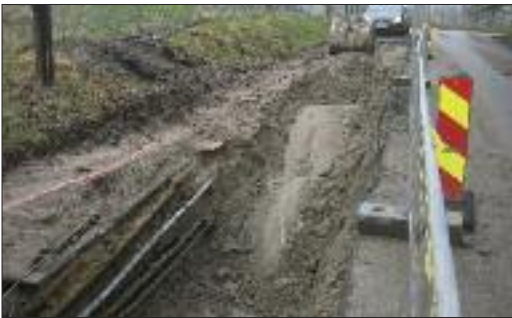
Grøft med fjell og kabler før sprenging.
