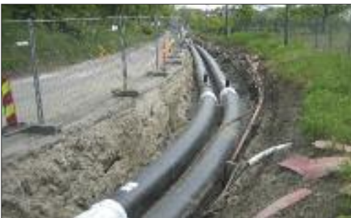
Grøft med fjell og kabler etter sprenging.
